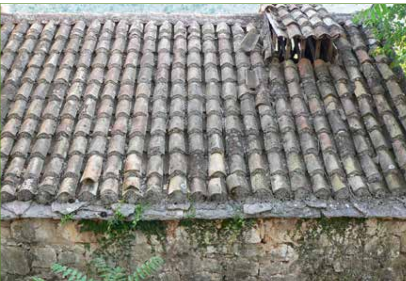
Krovni pokrov kupom kanalicom u Vidonjama
