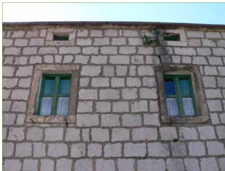
Kameni zid kuće u Rabi
