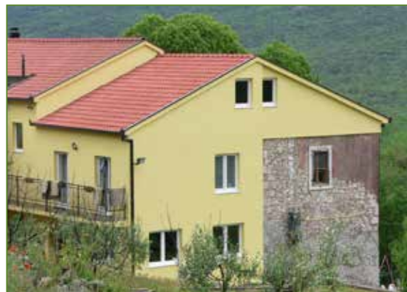
Loš primjer nadogradnje stare kuće
