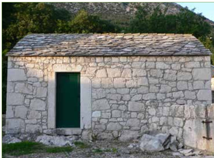
Krovni pokrov kamenim pločama u Desnama
