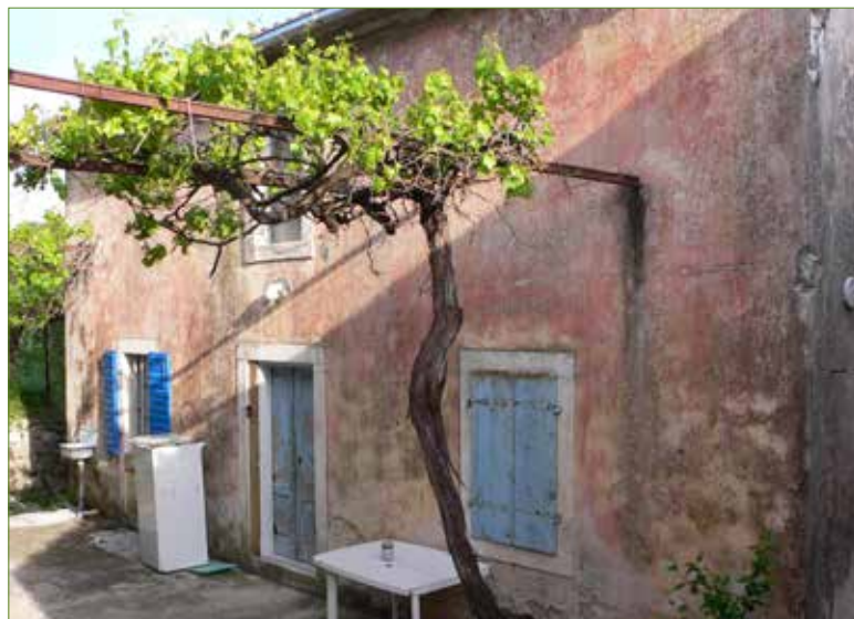
Ožbukano pročelje u zaseoku Rudine-Katići
